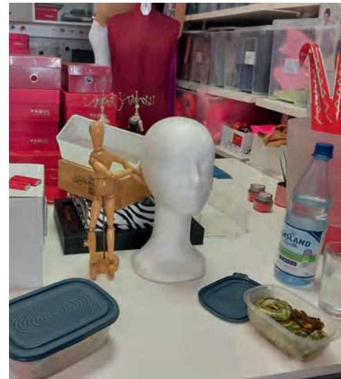
Während der Umbauarbeiten blieb für ausgiebige Mahlzeiten nur wenig Zeit. Foto: privat
